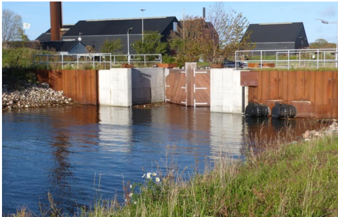
Figur 2 Højvandsport i Frederiksværk. Eksempel på en stormflodport med lukkeporte der tillader gennemsejling af mindre både.
