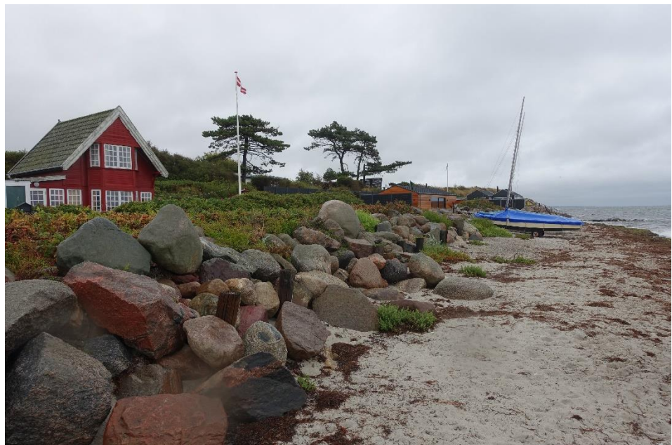
Figur 6.3: Skråningsbeskyttelse med sten foran udsigtsbolig. Foto: NIRAS A/S d. 10-09-2019.
