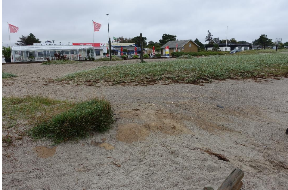
Figur 2.5: Den blottede lerkerne på det eksisterende dige langs kysten af Lungshave. Foto: NIRAS A/S d. 10-09-2019.
