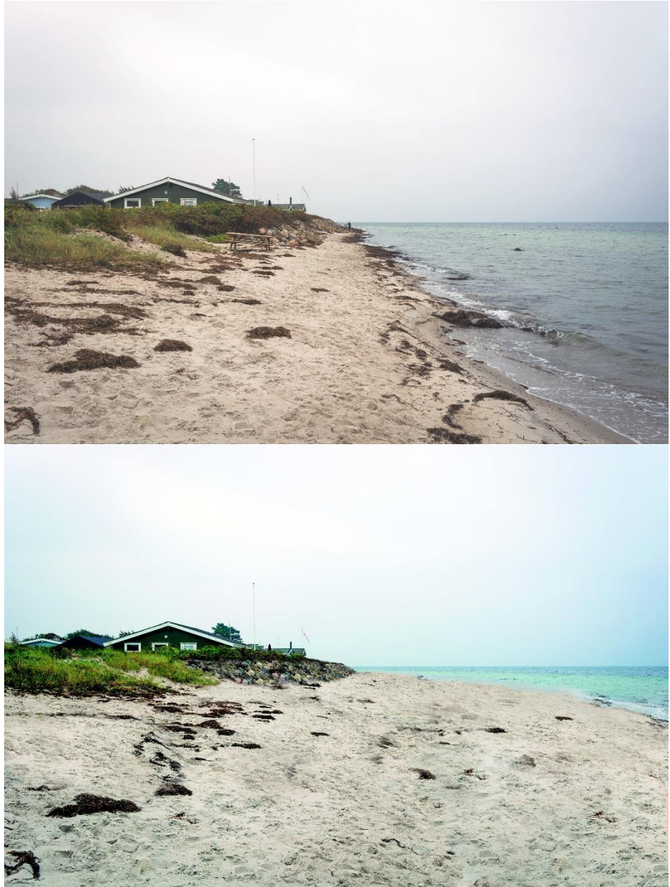
Figur 6.7: Visualisering af påvirkningen udfør område A. Øverst de eksisterende forhold og nederst de fremtidige forhold. Umiddelbart efter strandfodringen og indtil første stormvejr vil sandet ligge højere op ad dige/skråningsbeskyttelse. Se mere i Visualiseringsrapport i bilag 4.
