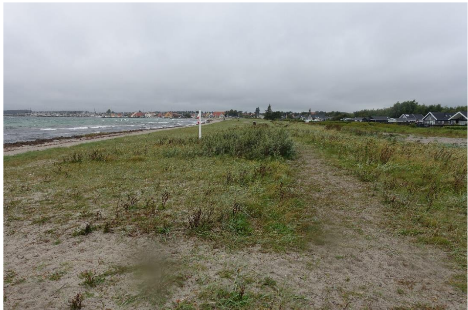
Figur 4.5: Kortlagt forklit på det eksisterende dige. Foto: NIRAS A/S d. 10-09-2019.
