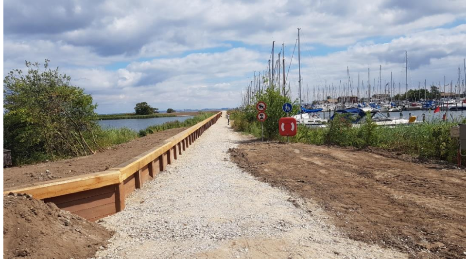
Figur 2.3: Eksempel på højvandsmur ved Nivå Havn udført i azobé-træ med stolper og flader og et topdække i lærk. Foto: NIRAS A/S.
