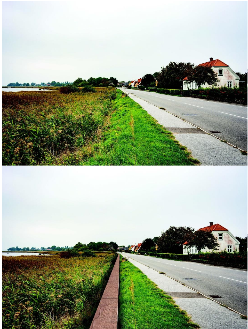
Figur 6.18: Visualisering af højvandsmuren langs med Enø Kystvej. Øverst de eksisterende forhold og nederst de fremtidige forhold. Se mere i Visualiseringsrapport i bilag 4.
