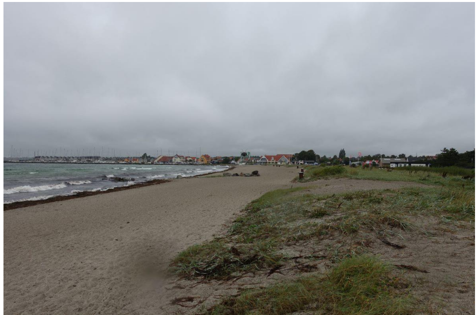
Figur 6.4: Den åbne og flade udligningskyst med eksisterende dige. Foto: NIRAS A/S d. 10-09-2019.
