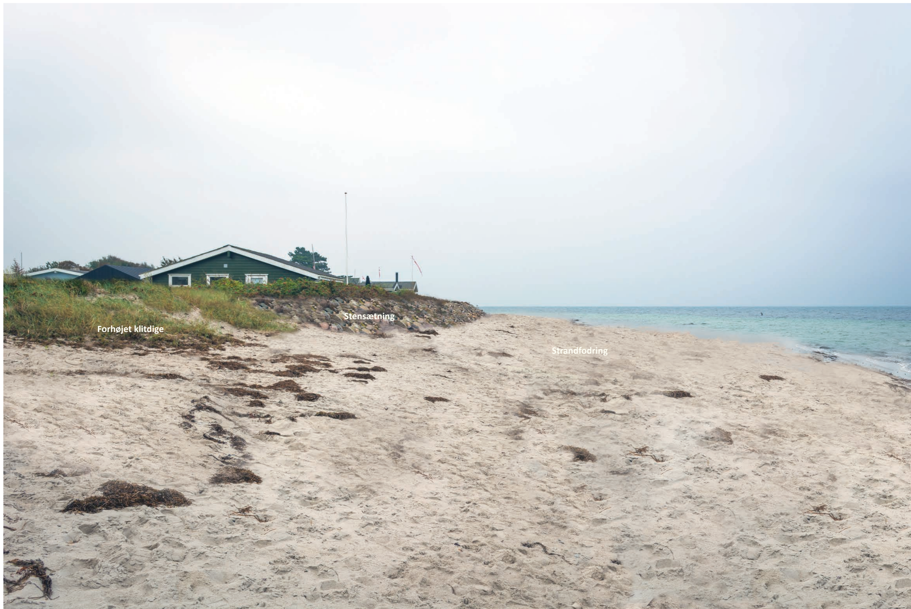
Fotostandpunkt 1 - Visualiseringen viser forhøjelse af klitdige og overgangen til skråningsbeskyttelsen samt nyanlagt strandfodring (sandet vil erodere væk indtil ny strandfodring hver 3. år).
