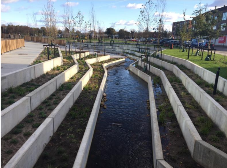
Figur 11.11: Område sikret mod høj vandstand i et vandløb ved trinvis sikring.
