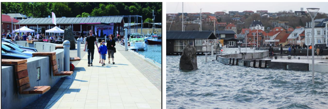
Figur 11.4: Højvandsmuren i Lemvig i en situation uden oversvømmelse, hvor pladserne indgår som en del af den bymæssige nærhed til vandet og i en situation med oversvømmelse, hvor arealerne søværts for højvandsmuren er oversvømmede. Billeder er fra (OranjeBeton, 2025) og er taget i hver sin retning.
