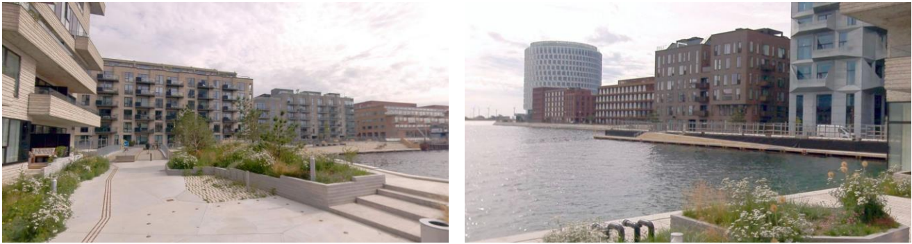
Figur 11.7: Byudviklingsområde i Nordhavn på tidligere havnearealer. Her er etableret kanaler med direkte forbindelse til Øresund og terrænet er generelt hævet og bygninger er opført således de er beskyttet mod oversvømmelse. COWI Gadefoto.
