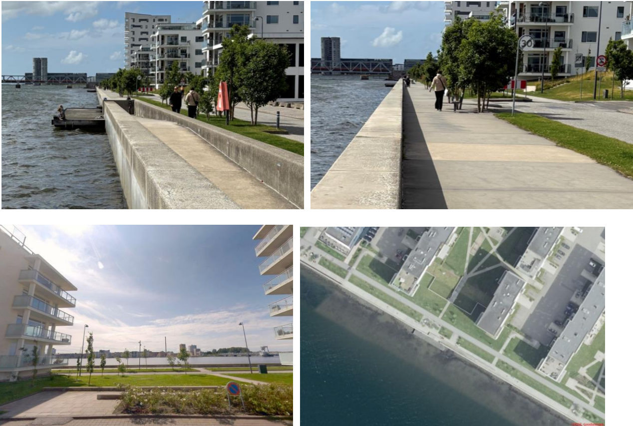
Figur 11.5: Højvandsikring bestående af højvandsmur ude langs kanten, bagved ligger betonplader, der er designet til at kunne modstå et evt. overskyl. Øverste billeder (NIRAS, 2025) og nederst til venstre er COWI Gadefotos, men oversigtsbilledet til højre er NIRAS Map.
