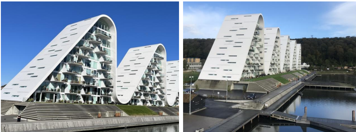
Figur 11.8: Billede af Bølgen i Vejle, hvor selve bygningen er etableret på et plateau, der sikrer bygningen mod oversvømmelse, mens adgangen til vandet er bibeholdt ved en trappeløsning. (NIRAS, 2022)
