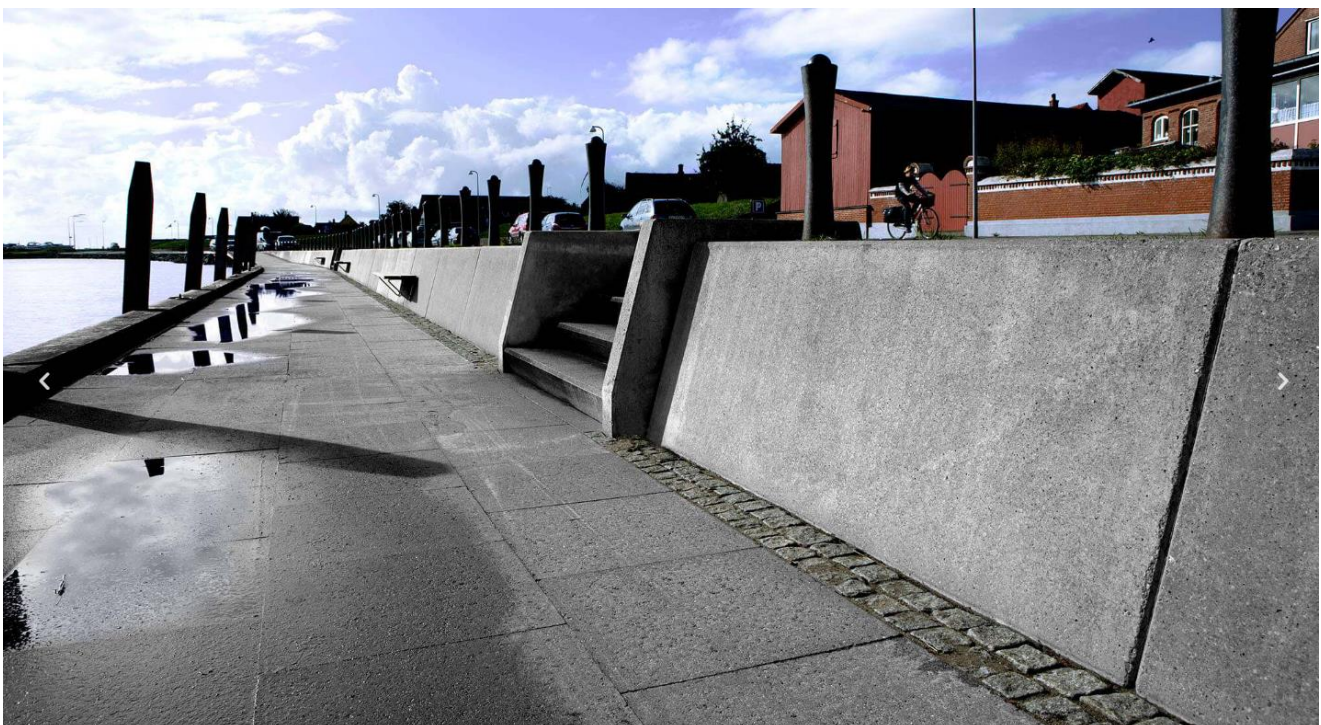
Figur 11.1: Højvandssikring på Fanø Havn. Billeder er fra (OranjeBeton, 2025)
