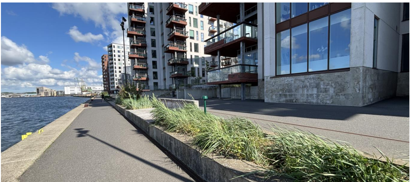
Figur 11.9: Byudvikling i Aalborg, hvor oprindelige kajkoter er bibeholdt og højvandssikring er etableret ved tilbagetrukne mure og hævet sokkelkote. Løsningen sikrer dermed en vis nærhed til vandet. (NIRAS, 2025)
