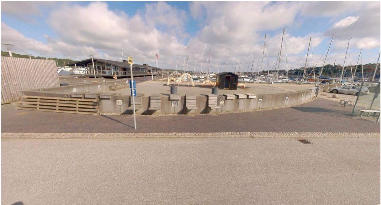
Figur 11.3: Gadebillede af højvandsmurens bugtende forløb med etablerede siddepladser. I baggrunden ses en hævet bygning, der er beliggende i det område der kan oversvømmes under stormflod. COWI Gadefotos.
