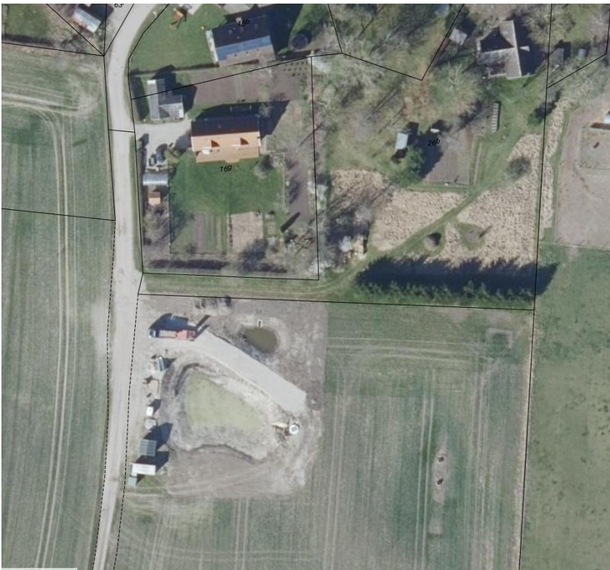
Af luftfoto 2025 fremgår det, at regnvandsbassinet allerede er etableret.
